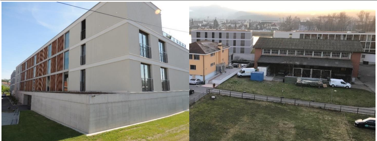
Abbildung 17; Foto Wohngebäude Parz. 1720 (Hunziker Architekten, 14.01.2020)
