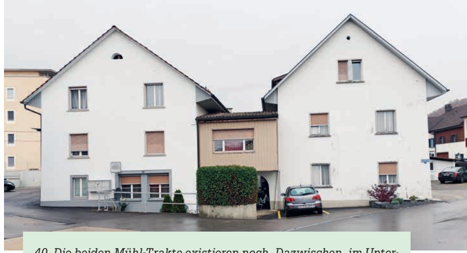
40 Die beiden Mühl-Trakte existieren noch. Dazwischen, im Untergrund, rauscht der obere Mühlebach (Birchmeier-Kanal).
