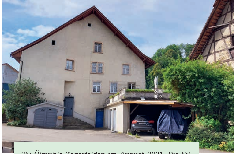
35: Ölmühle Tegerfelden im August 2021. Die Silhouette des Gebäudes blieb erhalten.
