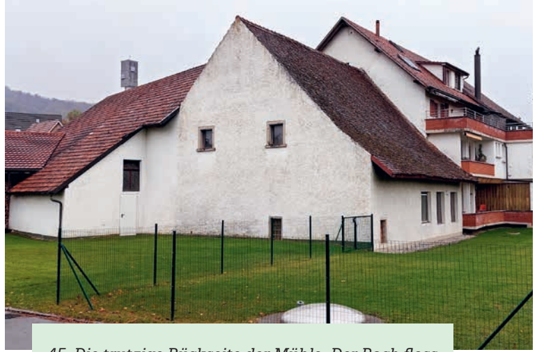
45 Die trutzige Rückseite der Mühle. Der Bach floss einst rechts dem Gebäude entlang und weiter dem Zaun folgend in die Aare.
