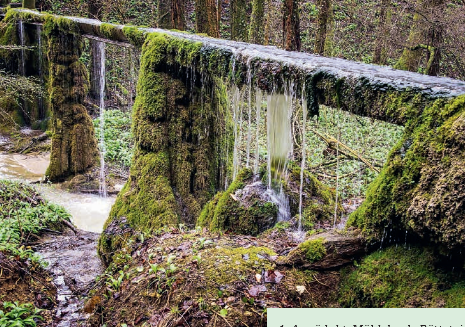
1 Aquädukt Mühlebach Böttstein zur Mengenregulierung
