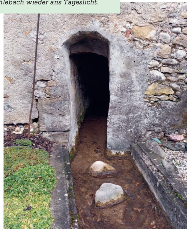
2 Unterhalb der Öli Böttstein tritt der Mühlebach wieder ans Tageslicht.
