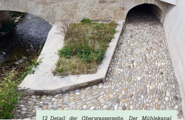
12 Detail der Oberwasserseite. Der Mühlekanal mit seinem Durchlass im westlichen Widerlager der Brücke wurde vor Jahren aufgegeben. Den Einlauf markiert seit der jüngsten Restaurierung eine Kieselsteinpflasterung. Foto DPAG, Christine Seiler, 2020.
