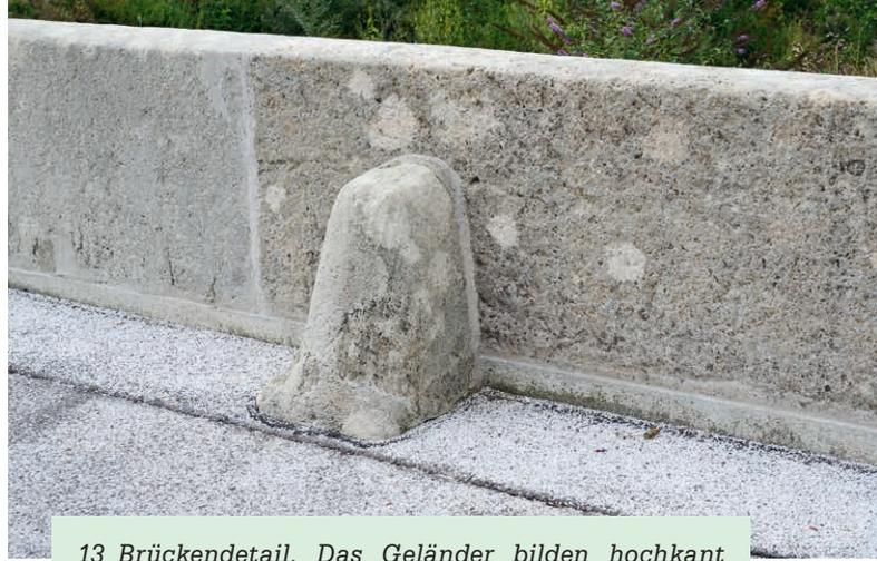
13 Brückendetail. Das Geländer bilden hochkant aufgestellte Platten aus Mägenwiler Muschelkalk. Diese Brüstungsplatten werden von konischen Radabweisern vor mechanischer Beschädigung geschützt. Foto DPAG, Christine Seiler, 2020.
